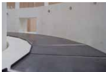
Поворотный стол с опорными пластинами из высококачественной жаростойкой стали для защиты изоляции
